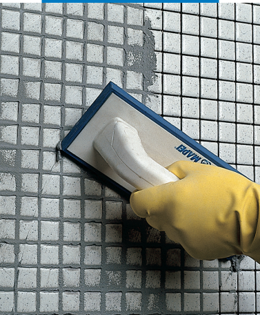
Spárování skleněné mozaiky stěrkou
