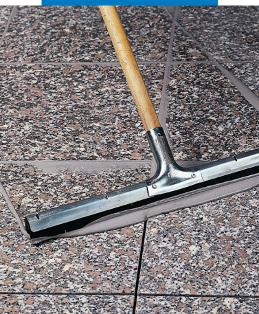
Spárování vyrovnaného a vyleštěného povrchu žulové dlažby pryžovou stěrkou
