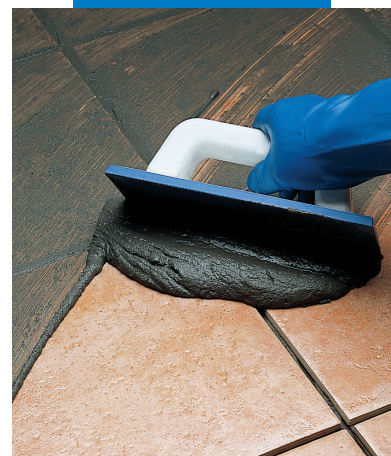
Spárování obkladů pryžovým hladítkem
