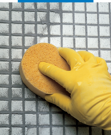
Dokončení povrchu skleněné mozaiky houbou
